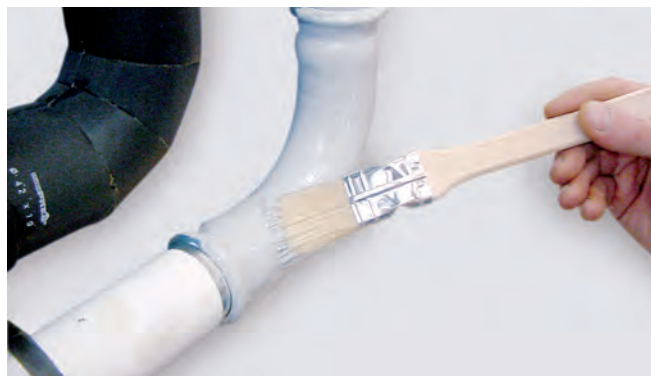
Ilustracja 42 – Malowanie podkładem rur i kształtek.
