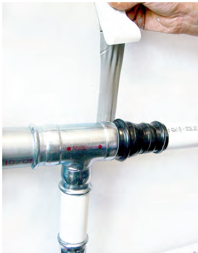
Ilustracja 43 – Ochrona połączeń taśmą butylową
