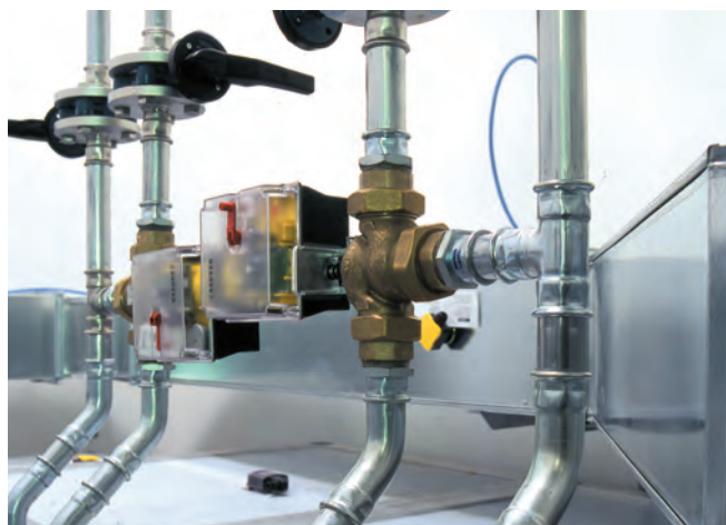
Ilustracja 23 - steelPRES – chłodnictwo (obieg zamknięty)
