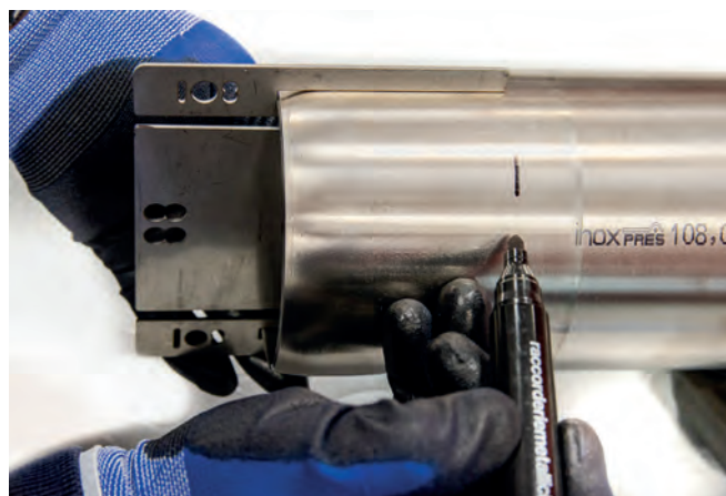
Ilustracja 29 – Oznaczanie głębokości włożenia za pomocą markera Ø 76 mm – Ø 88 mm – Ø 108 mm
