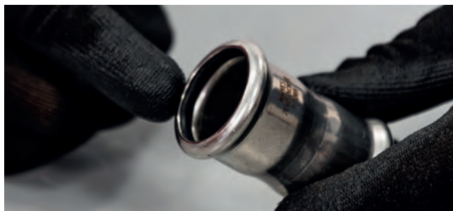
Ilustracja 35 – Sprawdzenie pierścienia uszczelniającego
